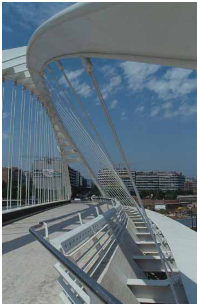
Il ponte pedonale e carrabile Felipe II a Barcellona.
